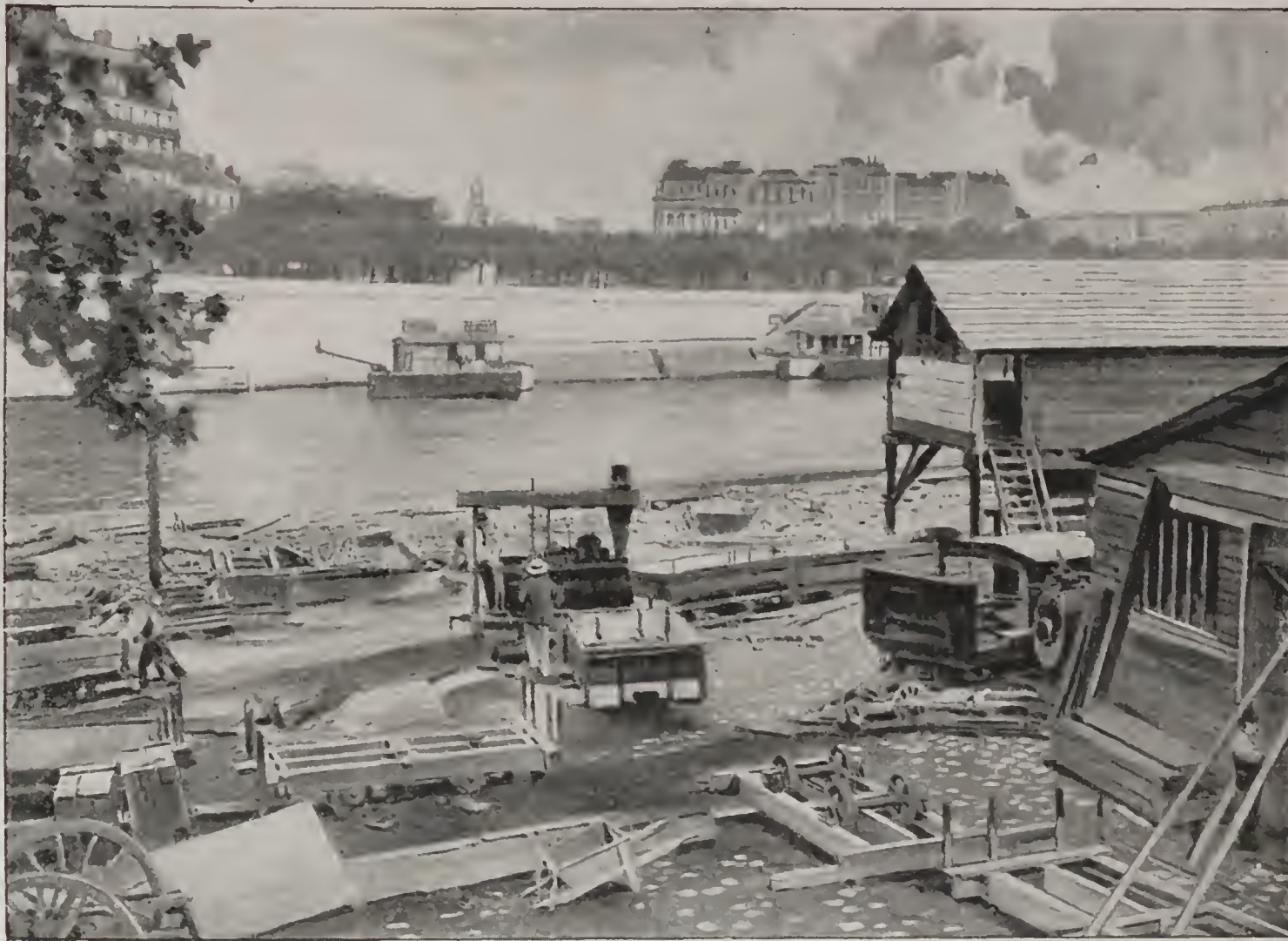
LE PROLONGEMENT DES LIGNES DE LA C ie D'ORLÉANS. — Chantier pour le dépôt du matériel.
